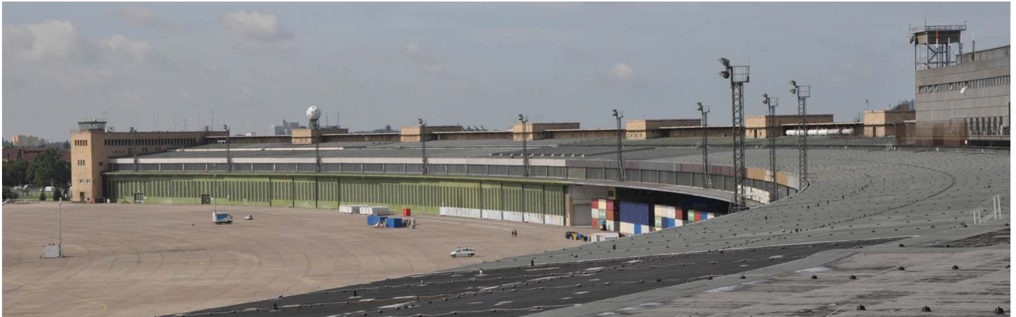
Dach des ehemaligen Flughafengebäudes Berlin-Tempelhof
